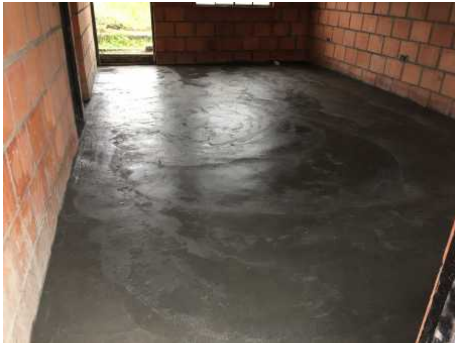
Terminación de pisos
